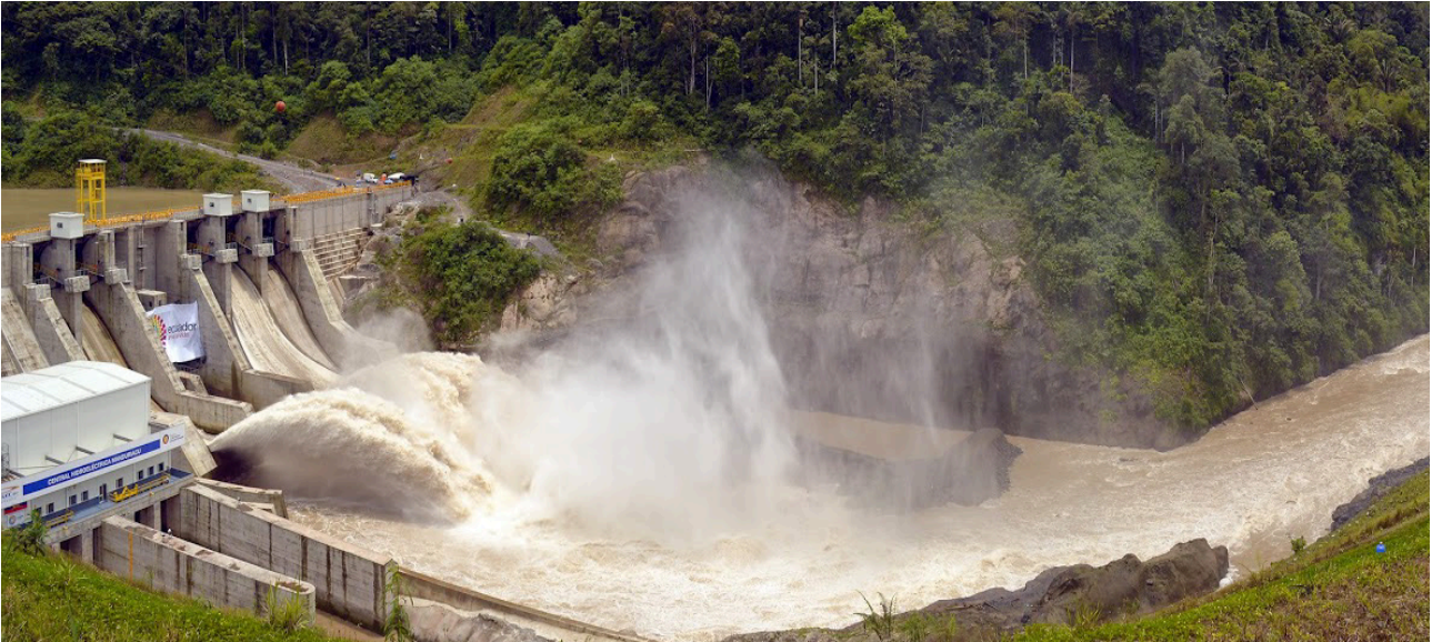
Figura Nro. 4-4: Presa de la Central Hidroeléctrica Manduriacu (65 MW)
