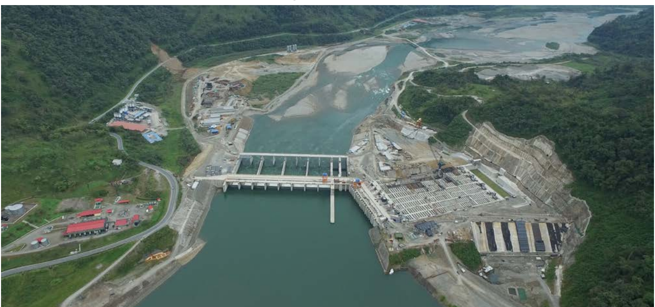
Figura Nro. 4-6: Obra de captación de la Central Hidroeléctrica Coca Codo Sinclair (1500 MW)
